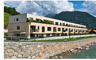
Complesso abitativo Residenza Raimund, Val di Vizze
