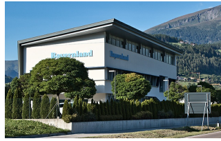
Fondazione profonda per la nuova sede amministrativa di Bayernland, Vipiteno
