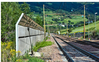
Barriera antirumore linea ferroviaria Verona-Brennero
