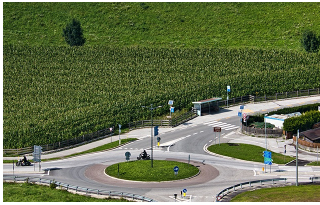
Errichtung Kreisverkehr auf der Staatsstraße SS44
