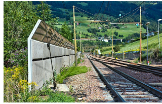
Lärmschutzwand Eisenbahnlinie Verona- Brenner
