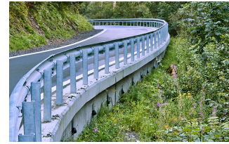
Sanierung der Landesstraße LS77 nach Ritzail
